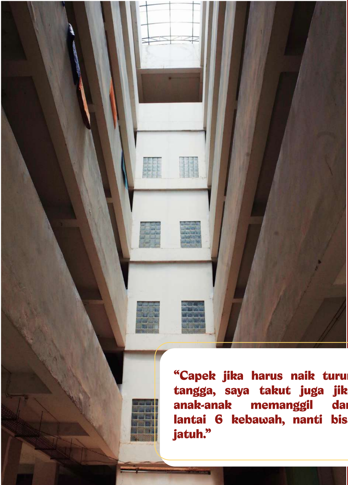
Gambar 28. Rusunawa Tambora blok F dengan enam lantai dan tanpa elevator
